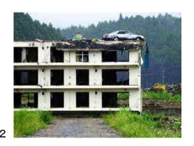
写真1: 上: 鉄筋コンクリート以外の建物が全壊浸水した岩手県陸前高田市の市街地
